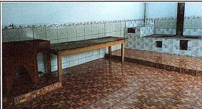
Foto1: . MADULO COCINA: COLOCACION DE PISO CERAMICO Y REPELLO
