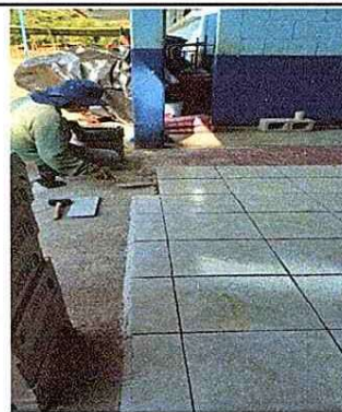
Foto 2: MODULO AULA: COLOCACIONDE PISO CERAMICO
