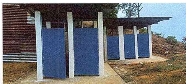
Foto 4: MODULO BAÑOS: COMBIO DE PUERTAS
