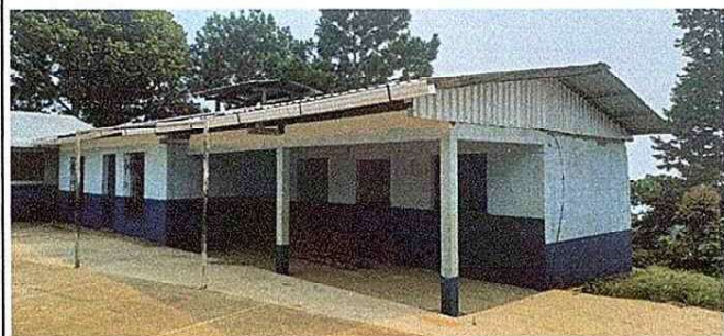
Foto 3: MODULO AULA: ESTRUCTURA Y TECHADO
